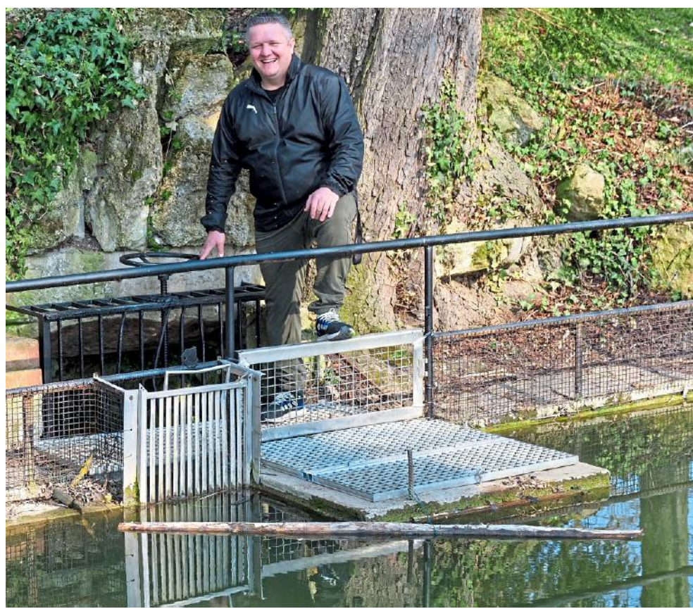
Endlich kann das Wasser wieder abfließen: Gewässerwart Andreas Schulz von den Sportfischern freut sich über die Verbesserung für den Monrepossee.
